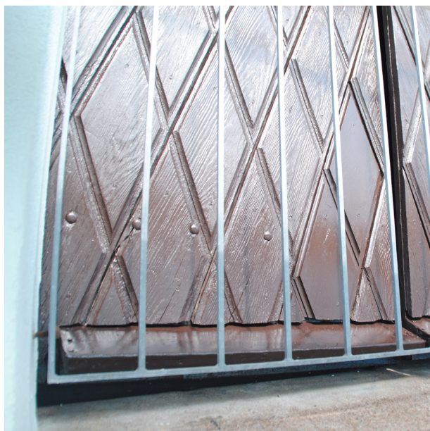
Ovan: Före ommålningen lagades alla rötskador i nederkanten på tornluckorna.
