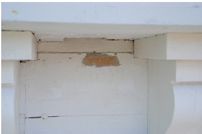
Ovan: Lanterninens fasader var i behov av ommålning och lösa färgskikt har skrapats ned. Virket i lanterninen är i gott skick.
