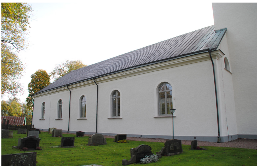
Långhuset från norr efter renovering.
