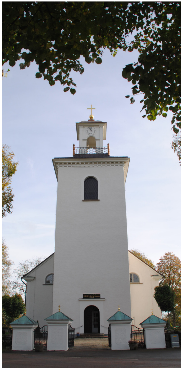
Kyrkans torn och grinstolparna in till kyrkogården efter renovering.
