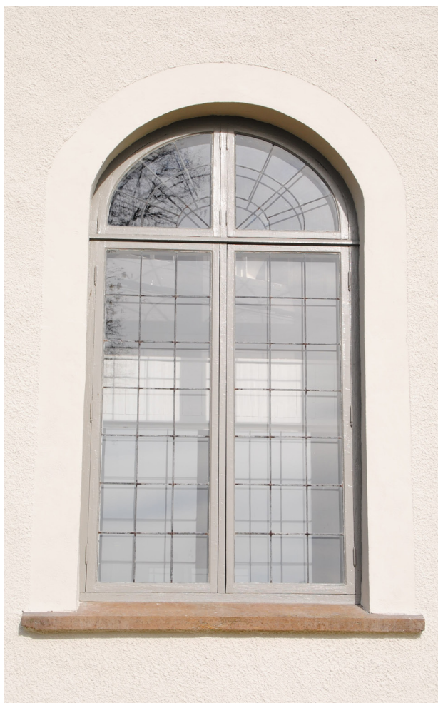
Ovan: Ett av södersidans fönster efter ommålning. Södersidans fönsterbågar målades om även på insidan.
