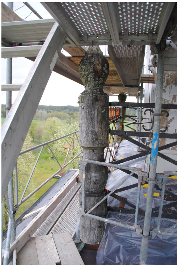
En av hörnstolparna i ek i lanterninen. Nya hörnstolpar tillverkades i slutet av 1990-talet. De placerades först för långt ut men flyttades senare till nuvarande placering.
