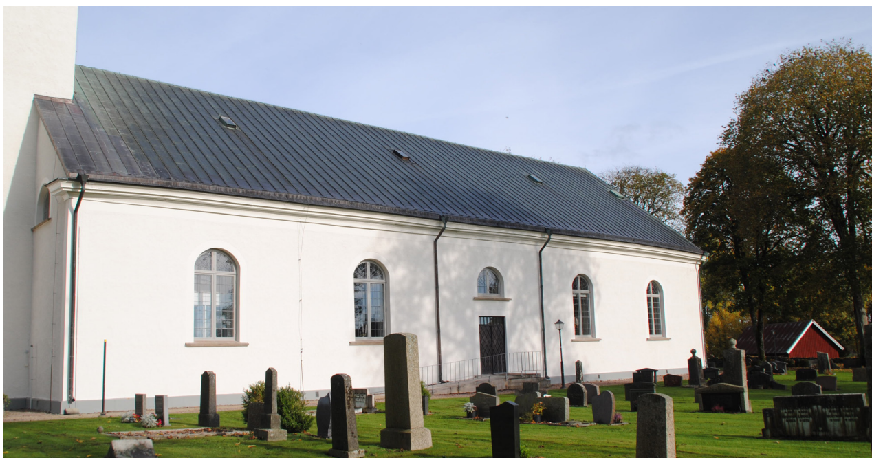
Ovan: Kyrkans södra fasad efter ommålning med silikatfärg.
