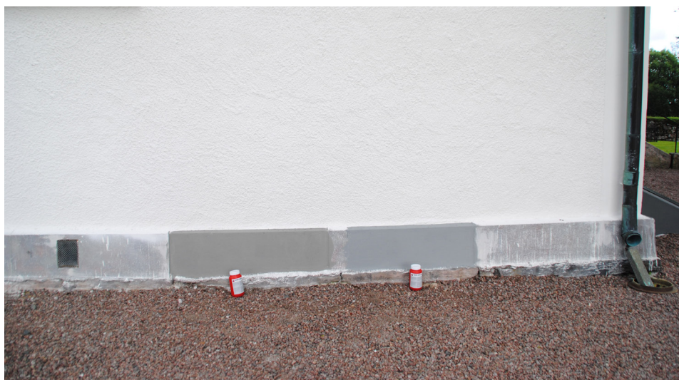
Provmålning av sockelfärgen. Båda kulörerna fungerade. Den vänstra låg närmre den valda fönsterkulören medan den högra låg närmre den kulör sockeln haft tidigare. Församlingens önskemål var den högra kulören vilken blev den som valdes.
