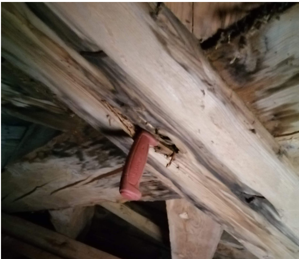
Ovan: Rötskador fanns även på lanternintakets takstolar och takbotten.
