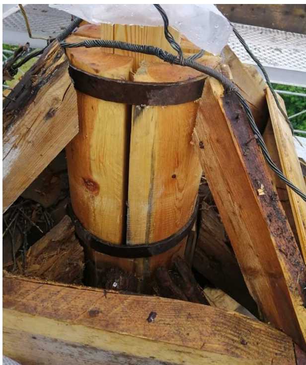
Det nya korset har monterats i en ny hjärtstock som ansluter till takstolarna i lanternintaket.
