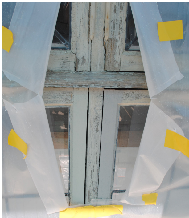
Provmålning av den grå kulören på kyrkans fönster.
