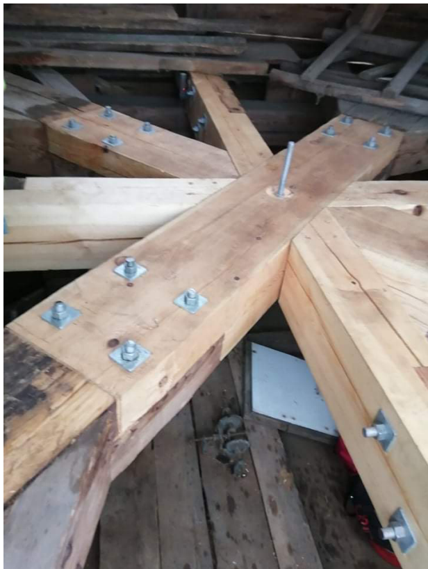
Det rötskadad krysset i lanterninentaket har reparats. Nytt trä har skarvats halvt i halvt med det gamla.
