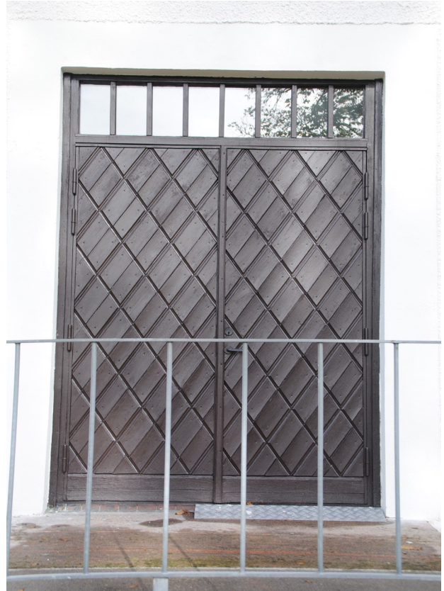
Södra entrén efter ommålning.
