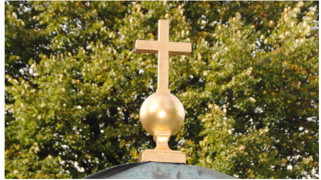
Ett av korsen på grindstolparna efter förgyllning med bladguld.
