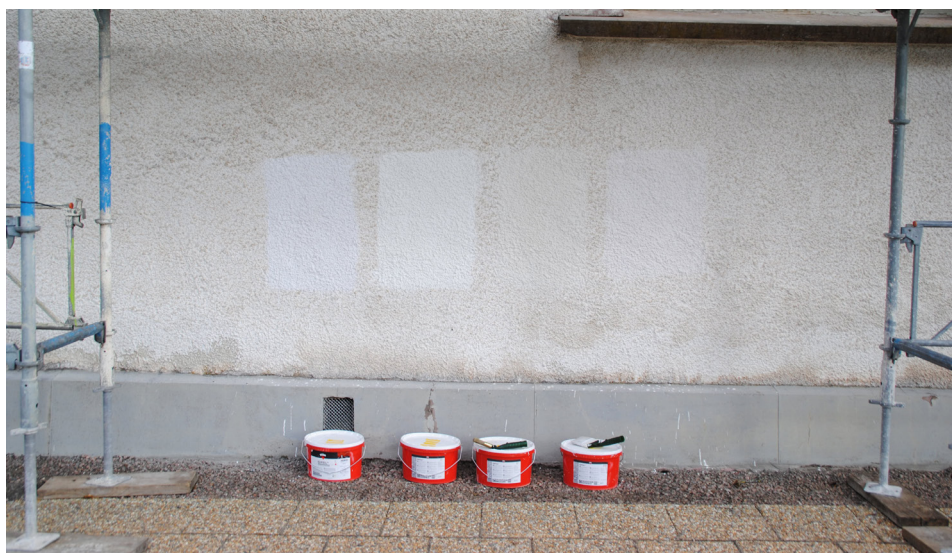
Provmålning på kyrkans fasad. Provmålningen resulterade i att två av kulörerna blandades för att hitta en varmvit kulör som passade kyrkans fasader.
