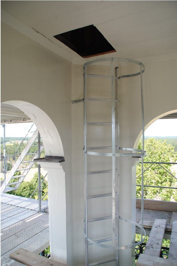
En större lucka har tagits upp i taket på lanterninen. En godkänd stege av aluminium med skyddsbur har monterats för tillgänglighet till utrymmet i lanternintaket där urverken till tornuren finns.
