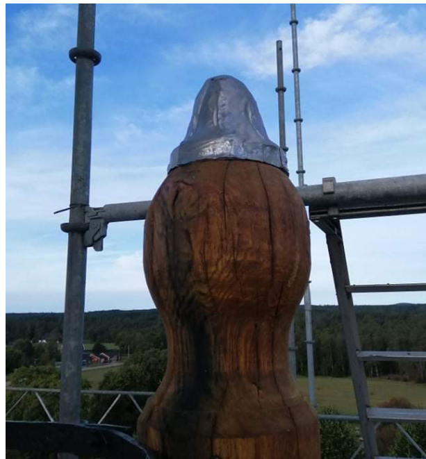
Till vänster och ovan: Nya svarvade stolpar i ek har monterats. De har behandlats med roslagsmahogny, vilket är lika delar trätjära, linolja och terpentin. Det beslutades även att de skulle få en skyddshätta av blyplåt.
