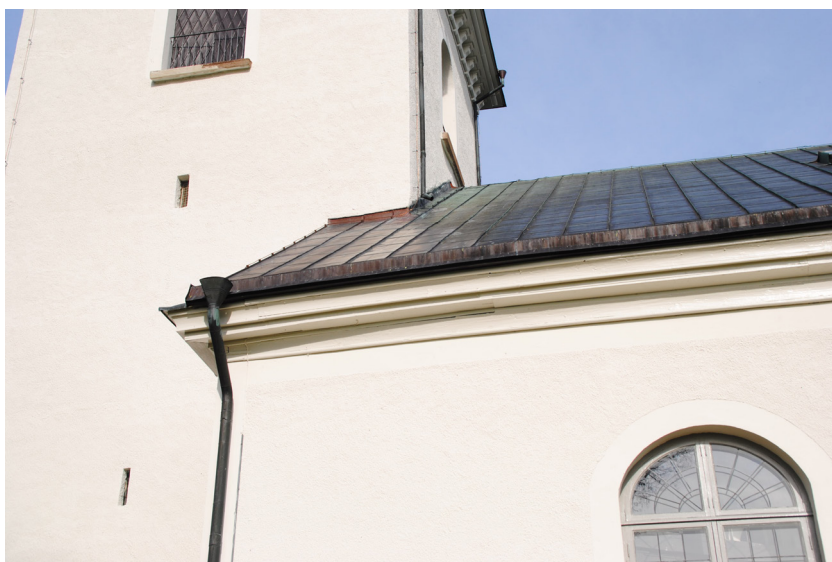
Ovan: Kyrkans södra fasad efter ommålning med silikatfärg.
