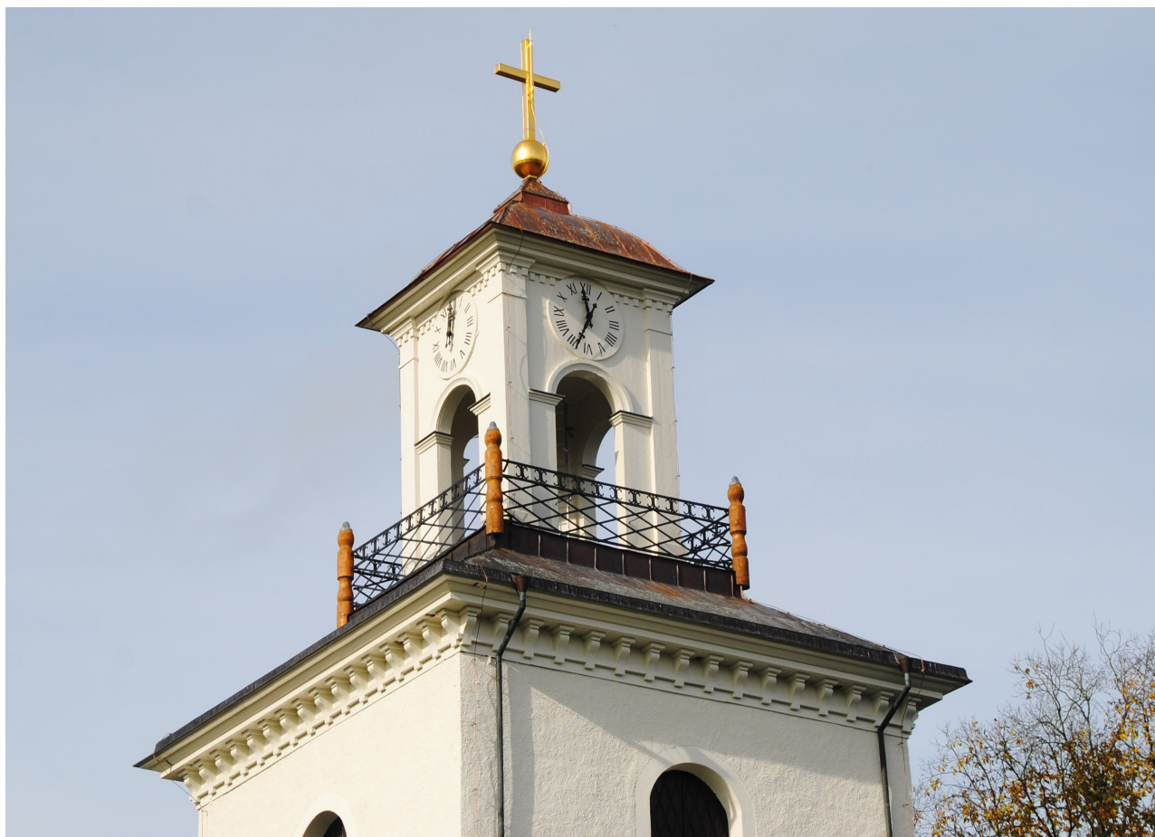
Lanterninen efter ommålning av fasader, tornur och smidesräcke och montering av nya svarvade hörnstolpar. Lanternintaket är omlagt med ny kopparplåt och korset har nytillverkats.
