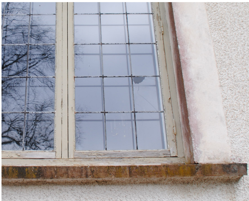
Ett av fönstren på långhuset södra sida. Färgskiktet var sämre på södra sidan än på norra, troligen för att södersidan är mer utsatt för solljus som bryter ner färgskiktet.
