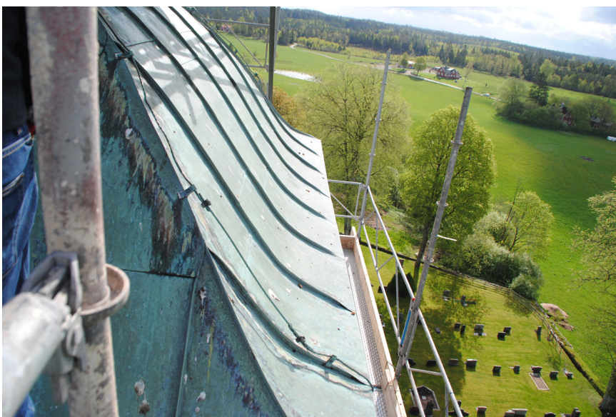
Lanternintaket har en svängd form och det saknar fotränna eller hängränna.
