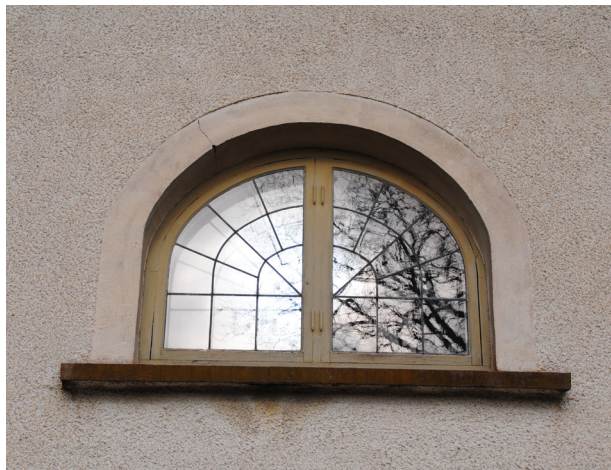
Lunettfönstret över södra entrén före ommålning.
