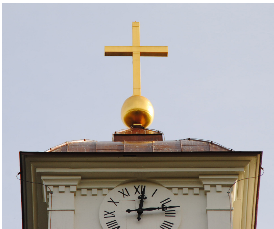
Det nya tornkorset har klätts med kopparplåt. Kulan har sparats från det gamla korset och monterats på det nya. Hela tornkorset inklusive kulan har förgyllts med 23 karats bladguld.
