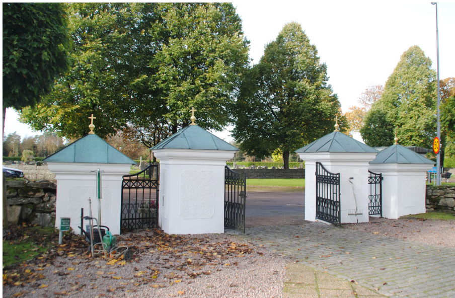
Grindstolparna ifrån kyrkogården efter renovering.
