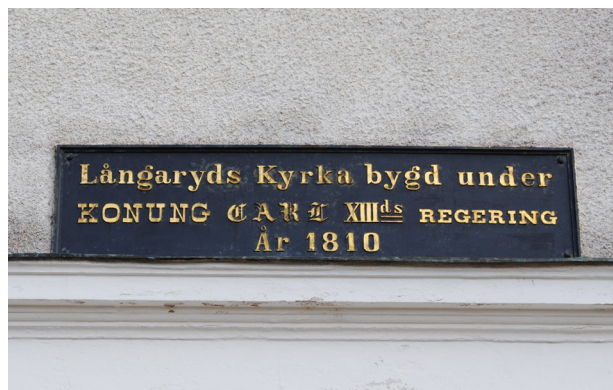
Över entrén finns en minnestavla över kyrkan uppförande. Förgyllningen började bli dålig.
