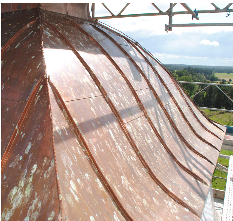
Lanternintaket har täckts om med ny kopparplåt i skivtäckning. Rötskador i takstolar och takbotten har lagats och ny papp har lagts på undertaket.
