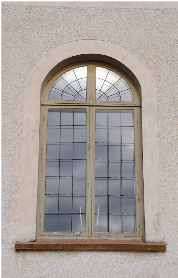
Ett av fönstren på långhuset södra sida. Färgskiktet var sämre på södra sidan än på norra, troligen för att södersidan är mer utsatt för solljus som bryter ner färgskiktet.
