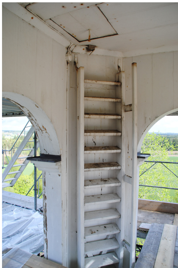
Inne i lanterninen fanns en trästege för tillgång till utrymmet uppe i lanterninen där urverken till tornuren finns. Luckan var liten och trång och stegen var inte godkänd att klättra på.
