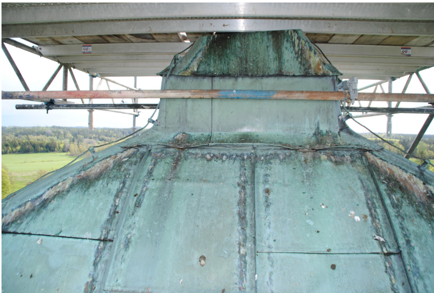
Lanternintaket före renovering. Taket är täckt med kopparsplåt i skivtäckning.
