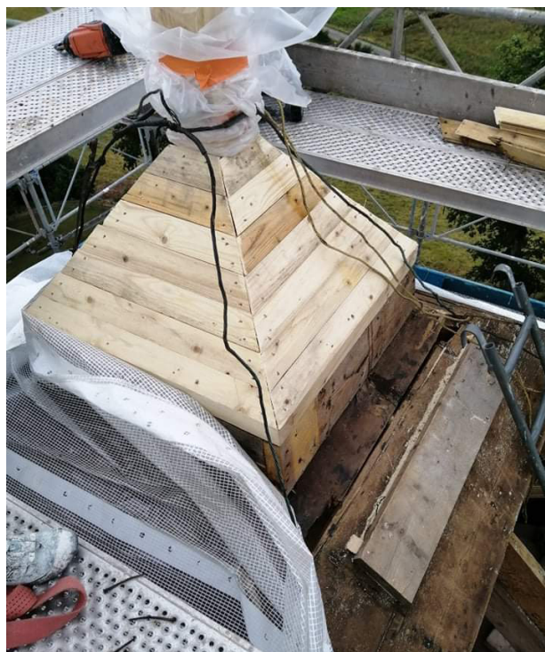
Ny takbotten har monterats på den lilla huv som ansluter till korset.
