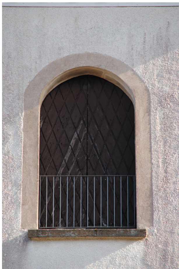
En av tornluckorna innan renovering. Förutom att de var i behov av ommålning fanns det även en del rötskador nedtill på luckorna.
