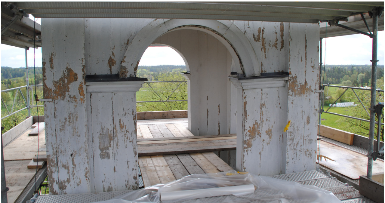
Ovan: Lanterninens fasader var i behov av ommålning och lösa färgskikt har skrapats ned. Virket i lanterninen är i gott skick.
