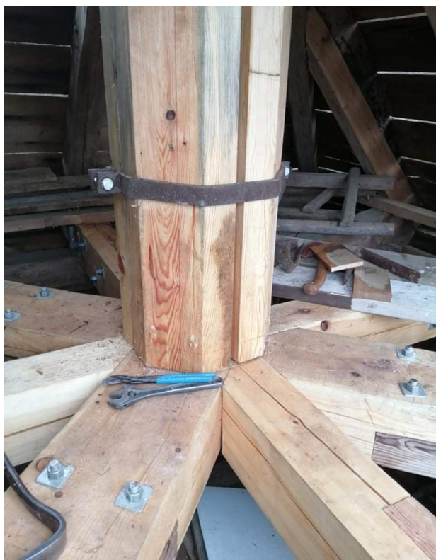
Tornkorset vilar på kryssset inne i lanternintaket.
