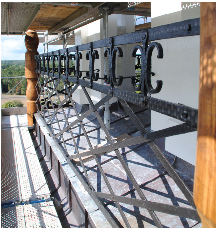
Till vänster och ovan: Nya svarvade stolpar i ek har monterats. De har behandlats med roslagsmahogny, vilket är lika delar trätjära, linolja och terpentin. Det beslutades även att de skulle få en skyddshätta av blyplåt.
