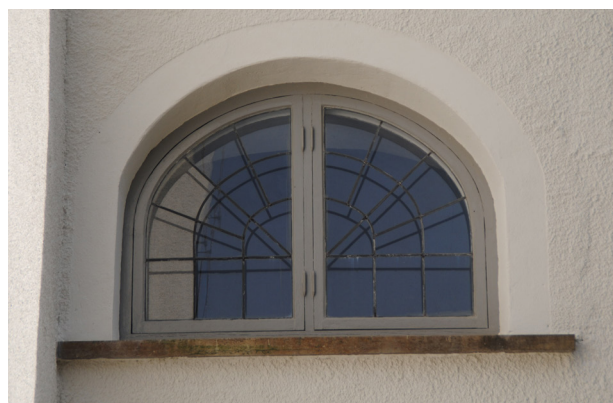
Ovan: Ett av södersidans fönster efter ommålning. Södersidans fönsterbågar målades om även på insidan.
