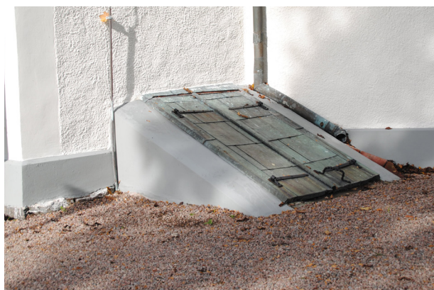
Källarnedgångens putsades sidor efter putslagning och ommålning med samma grå silikatfärg som sockeln.
