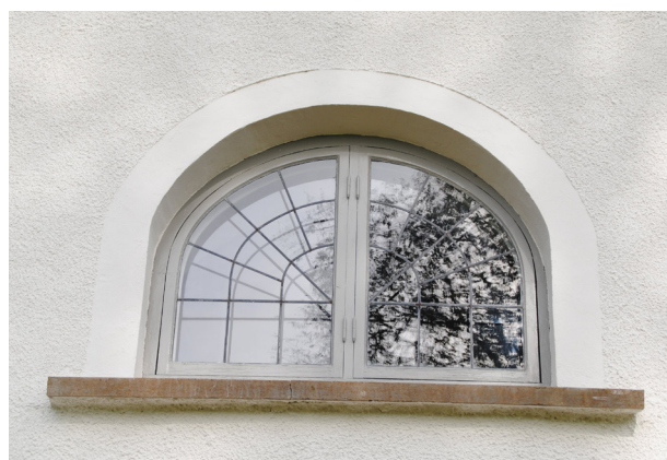
Lunettfönstret över den södra entrén efter ommålning med grå linoljefärg.
