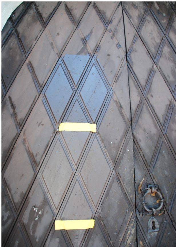
Ovan: Före ommålningen lagades alla rötskador i nederkanten på tornluckorna.
