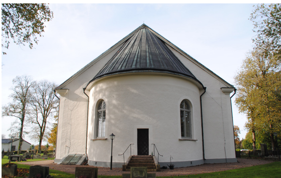
Sakristian efter renovering.
